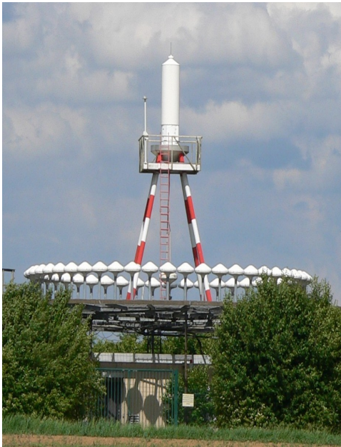
Drehfunkfeuer-Station in Aichtal, Deutschland (Quelle: de.wikipedia.org/wiki/Drehfunkfeuer )
